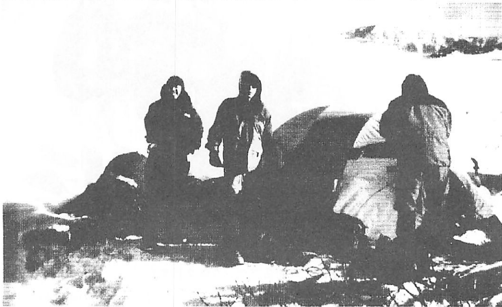
ボーコン沢の頭にて…ボーコンハイツ建設中
